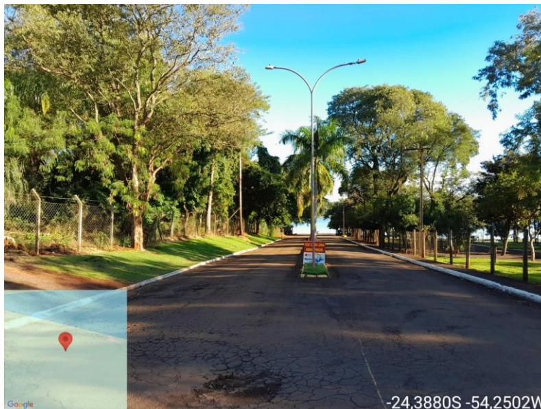
Foto 01: Visão frontal da localização do portal.
